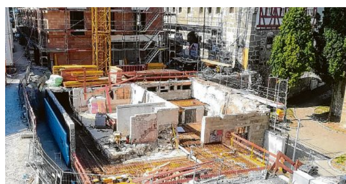
Endspurt. Haus für Haus werden die Rohbauten an der Grabenstraße in Gaildorf hochgezogen. Als letztes der fünf Gebäude geht es nun an das Bräuhaus. Eine neue Außenwand des Kellers steht schon.
